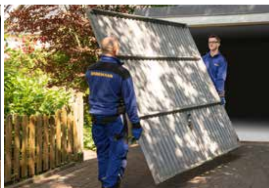
Ausbau und umweltgerechte Entsorgung
